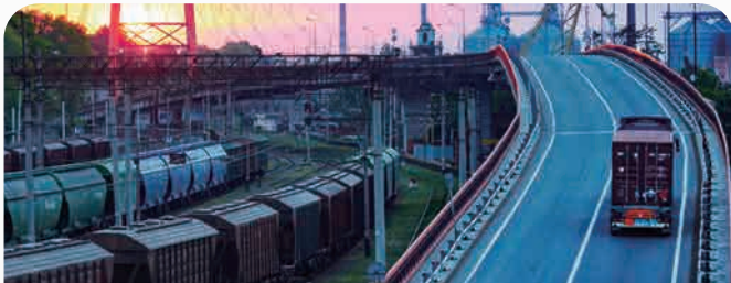
公路/铁路/港口
